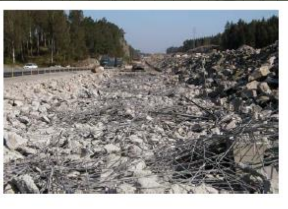
RUŠENJE AB KONSTRUKCIJE
