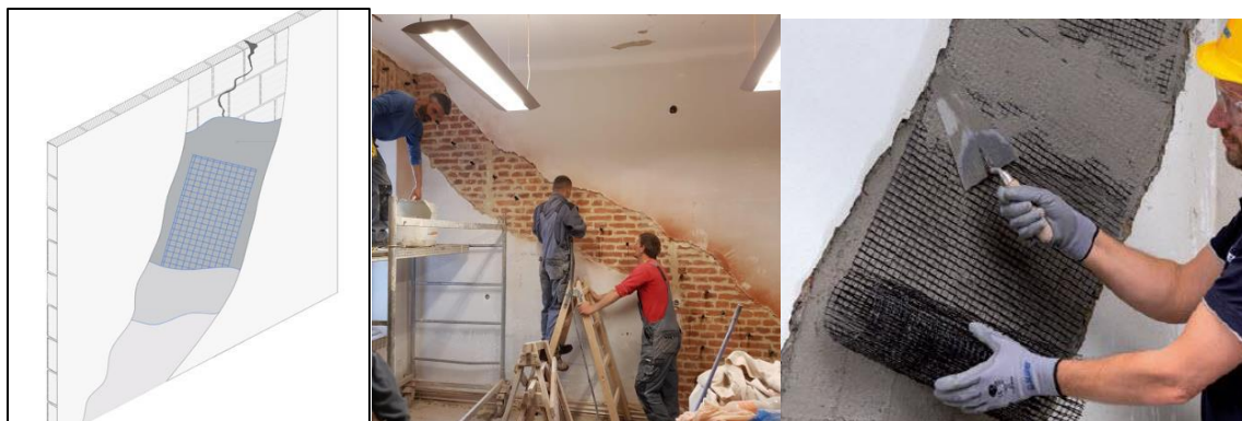
Slika B.3.6. – Popravak pukotina FRCM sustavom
