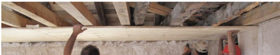
Slika B.3.8. – Pojačanje stropnih grednika drvenom pločom s donje strane
