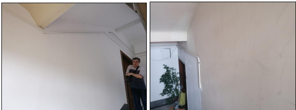
Slika B.2.11. Zidovi stubišta bez oštećenja
