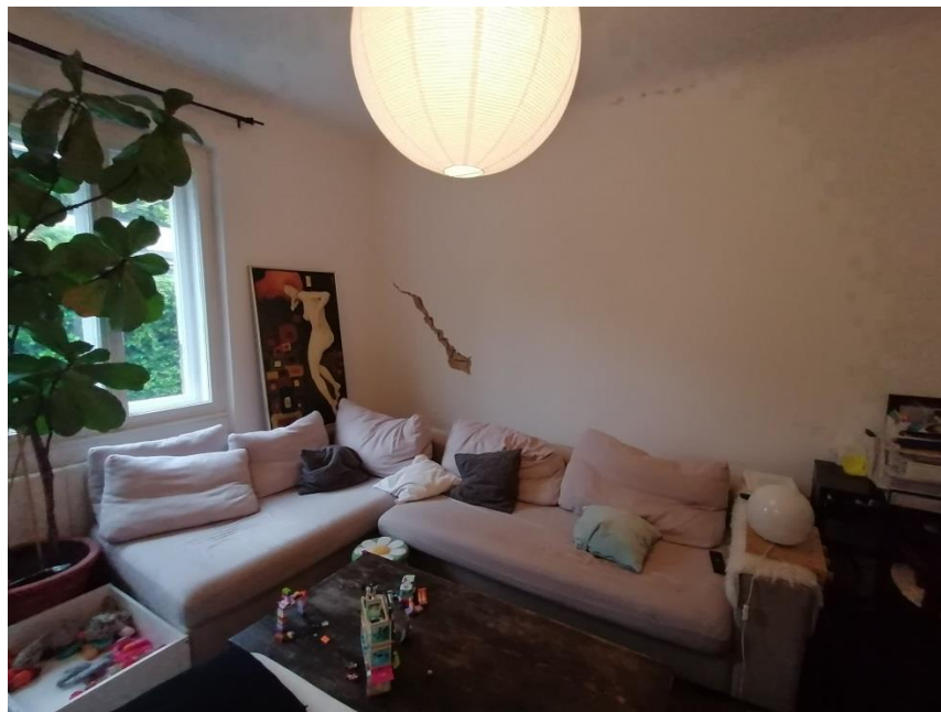
Slika B.2.17. Oštećenje zabatnih zidova – kosa dijagonalna pukotina
