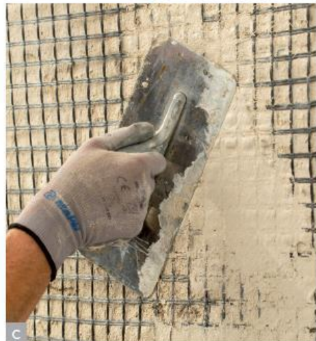
Slika B.3.13. – Pojačanje zida FRCM sustavom
