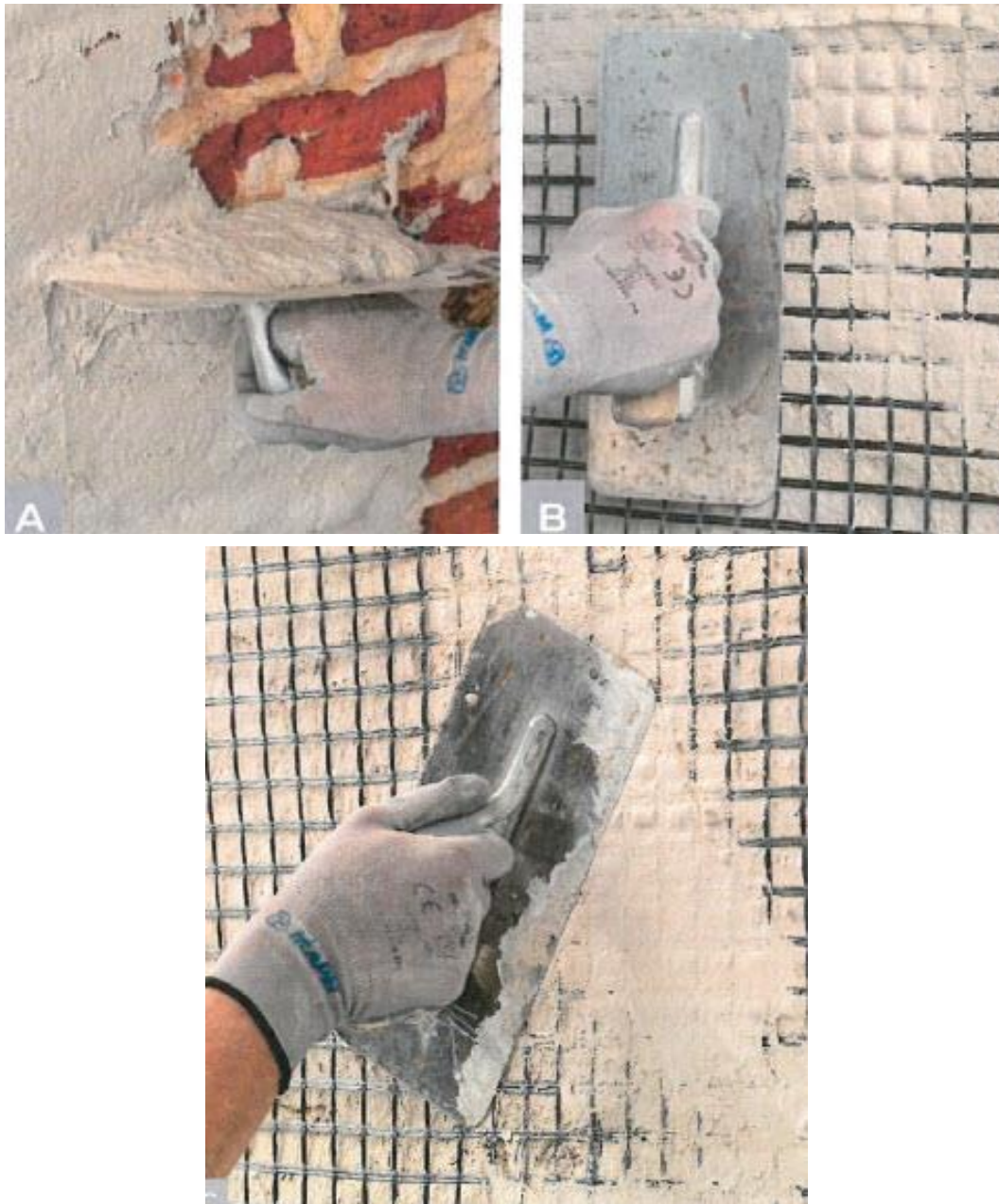
C.3.3.3 – Prikaz izvedbe FRCM sustava
