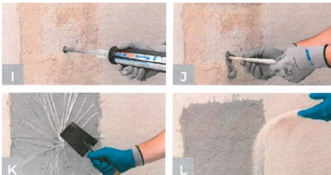
C.3.3.6. – Sidrena užad Mapewrap Fiocco- postupak I-L
