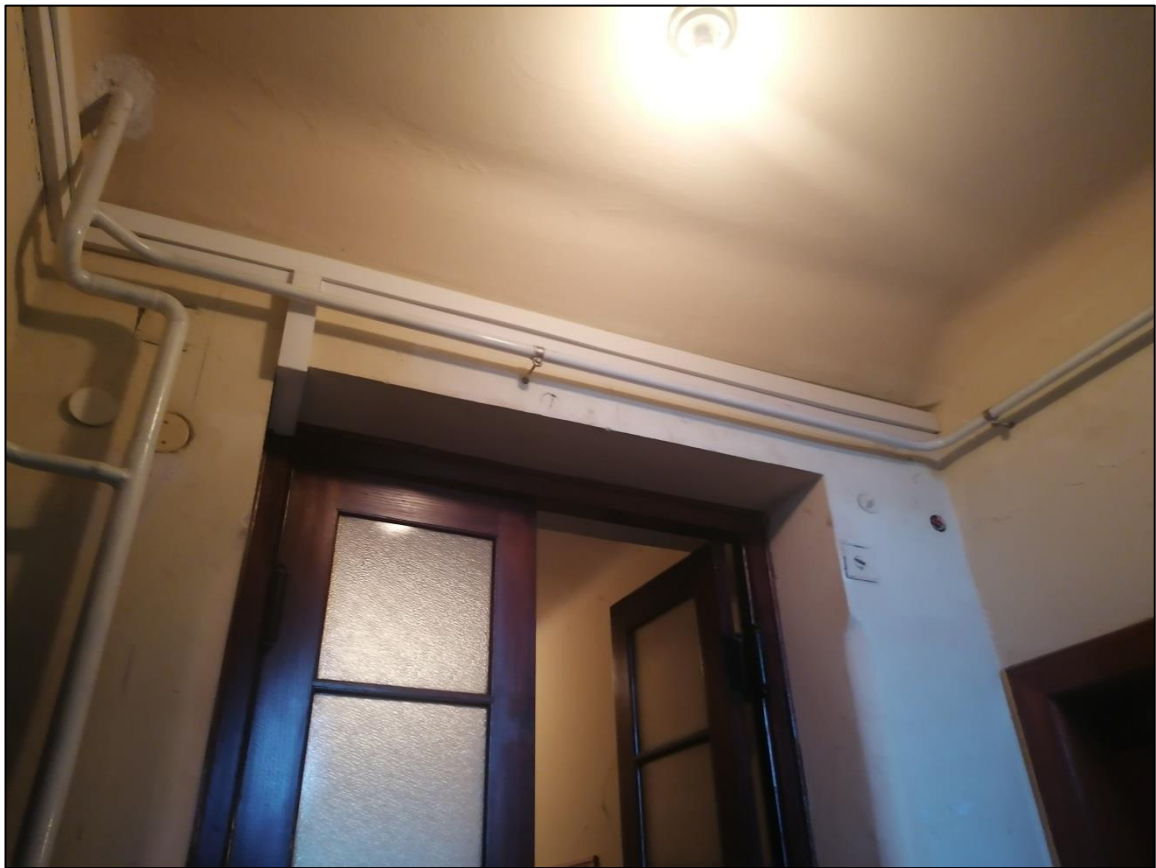
Slika B.2.10. Ulaz u prizemlju na stubištu
