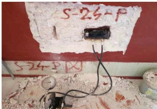
Slika 24. Izmjera zida i sastav (ispitivanje i posmične čvrstoće zida)
