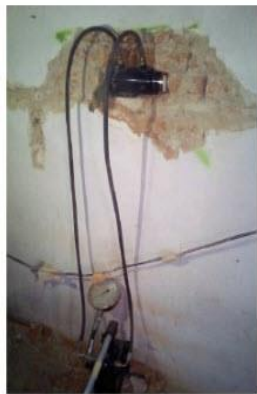
Slika 25. Priprema ispitivanja posmične čvrstoće zida na mjestu J-1
