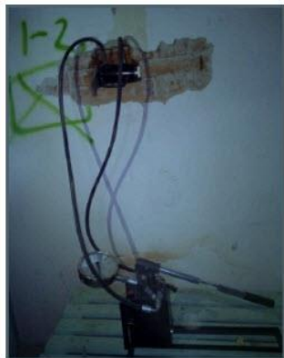
Slika 24. Priprema ispitivanja posmične čvrstoće zida na mjestu J-2
