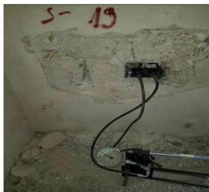
Slika 20. Izmjera zida i sastav (ispitivanje i posmične čvrstoće zida)
